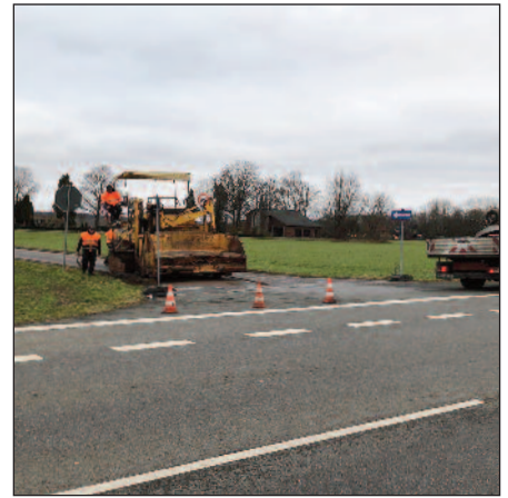
Bankette an der Steinbreite werden instand gesetzt.
