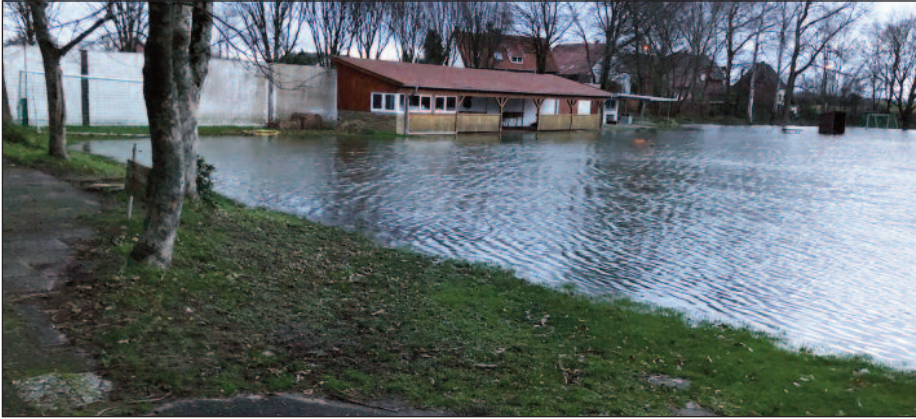
Sportplatz Wietersheim unter Wasser
