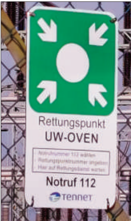
Rettungspunkt am Umspannwerk Ovenstätt
